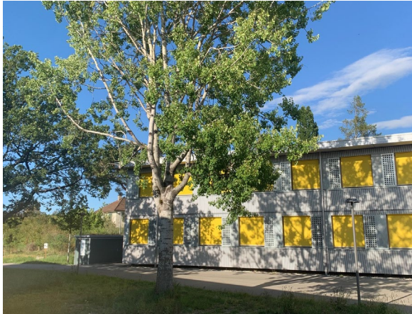
Schulbauten (Bild Provisorium Brünen) Sandrainstrasse 17a & 17b
